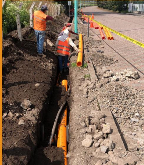
Al momento el proceso de repotenciación por parte de la Empresa Eléctrica Quito (EEQ) se encuentra en plena ejecución realizando la colocación de tubería para nuevos ramales de conexión. Adicional se empezó el proceso de ampliación de CS1, CS2 y los CS adicionales desde donde se podrán conectar cada uno de los copropietarios a la red principal.
